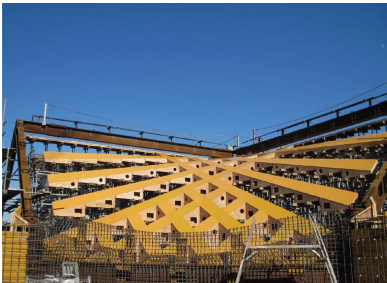
■ヤマザキパン中央研修所兼研修センター(施工中)
