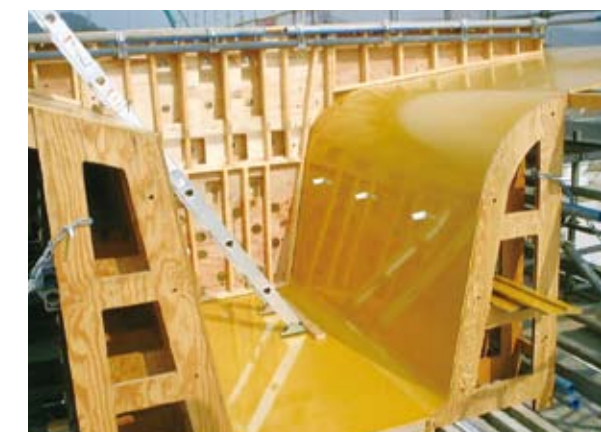
■渡良瀬第一高架橋(施工中)
