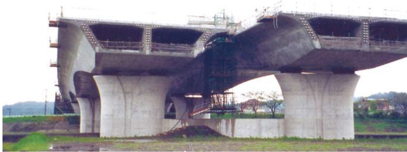
■第二東名高速道路太田橋(施工中)
