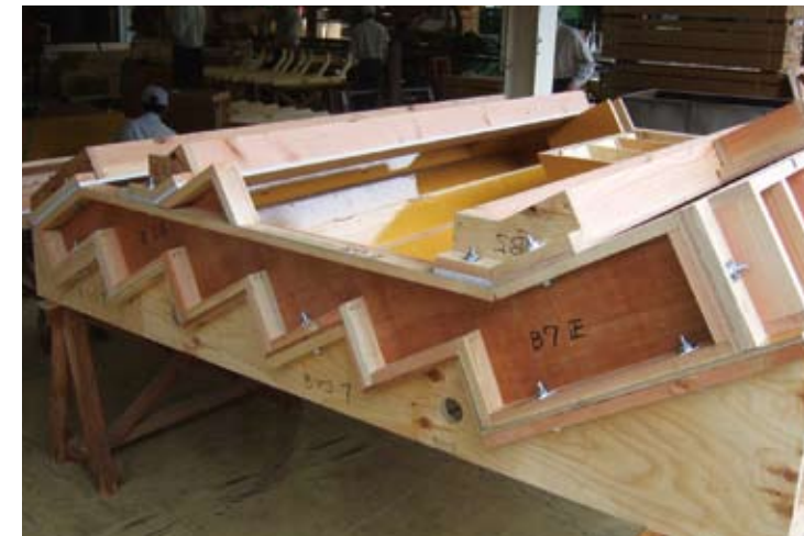
■階段型枠(日本青年館・日本スポーツ振興センター本部棟新営)
