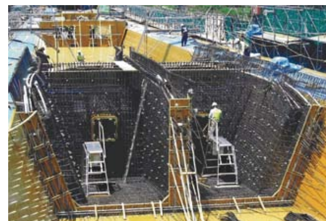
■ボックス桁 内枠(施工中)
