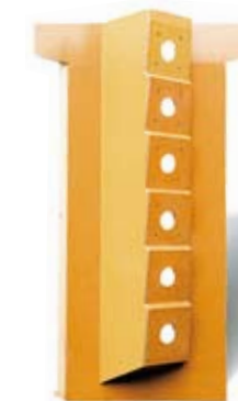
■ボックス桁 内枠(施工中)
