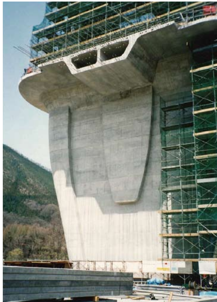
■尾瀬大橋(施工中)
