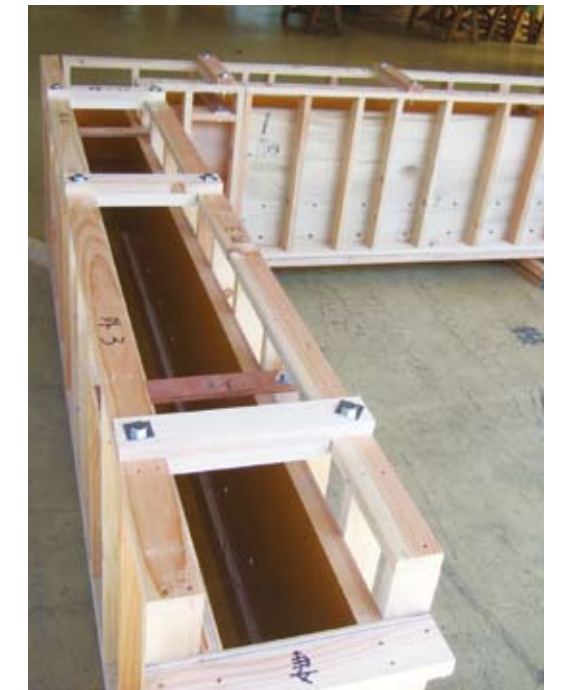
■パラベット型枠(横浜市戸塚区品濃町計画)
